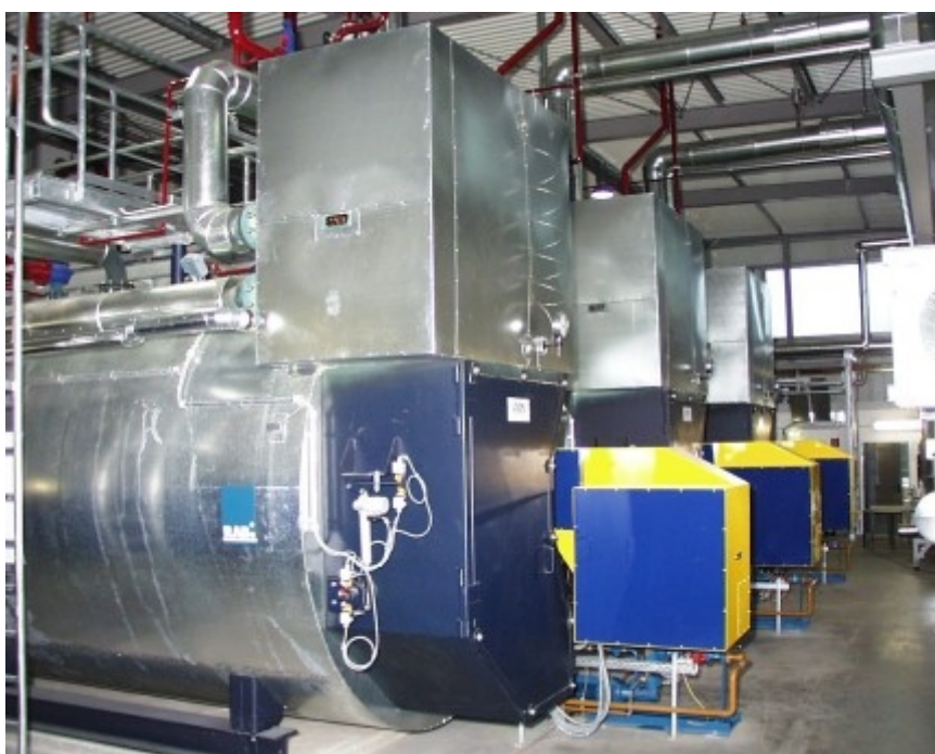
Przykład zastosowania 3 kotłów parowych z przegrzewaczami w fabryce papieru
