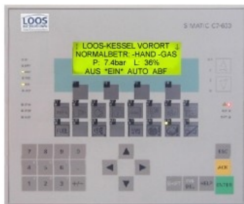
Przejrzyste dane robocze w menu (przykład) W menu regulacji poziomu podawane są wartości zadane i rzeczywiste oraz górna i dolna wartość graniczna punktów włączenia/wyłączenia.
