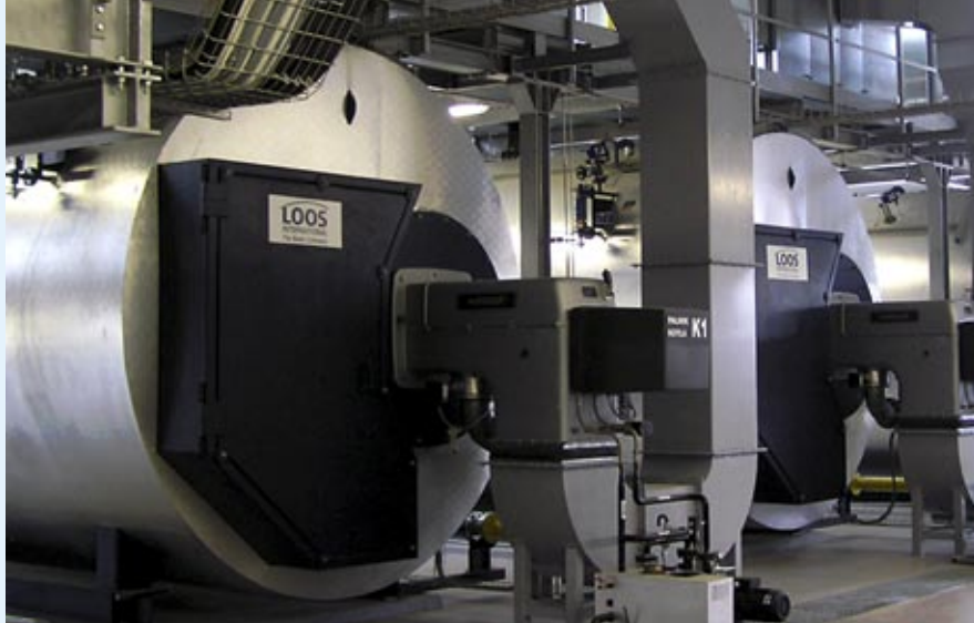
Rys. 2 Kotle parowe LOOS z zintegrowanymi ekonomizerami
