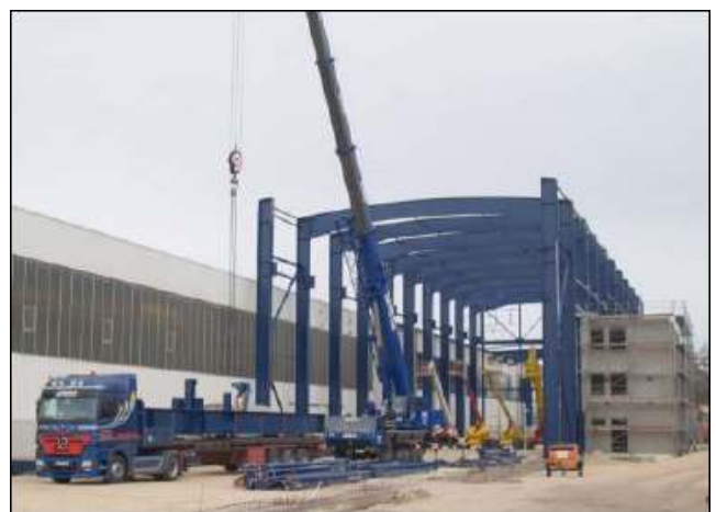
Budowa stalowego rusztowania.
