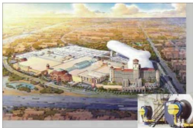
Dwa kotły parowe firmy LOOS gwarantują dostawę energii do kompleksu hotelowego
