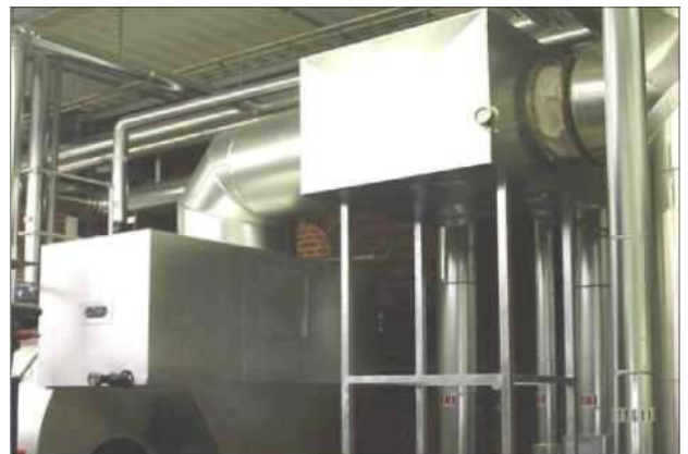
Klasyczny sposób odzyskiwania ciepła ze strumienia spalin przez ekonomizer i kondensator spalin.
